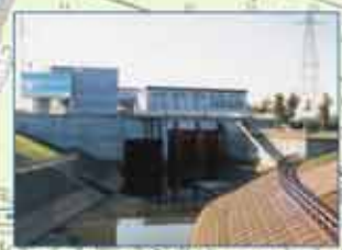
池の前排水機場
