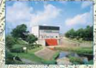
滝川排水機場
