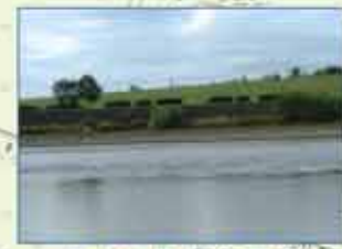
橋本橋門下流護岸
