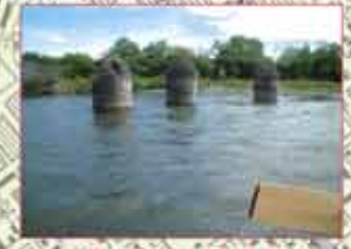
空知大橋旧橋脚
